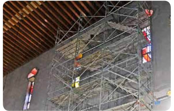
聖堂内部の天井と壁の劣化調査
