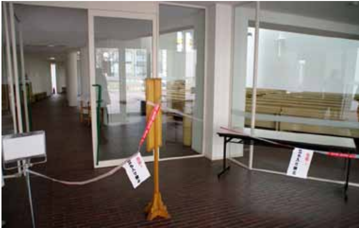
仙台教区 カテドラル 元寺小路教会内部の様子 (度重なる余震で一部損壊、使用不能の状態になっている)
