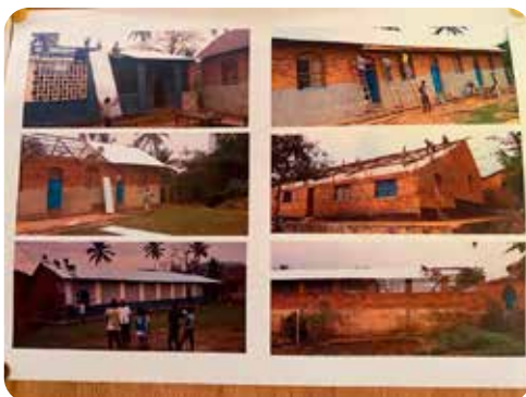
カンゲー寮改築の様子
