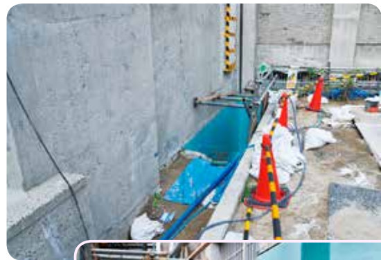
世界平和記念聖堂の後方、地下聖堂の防水工事の様子
