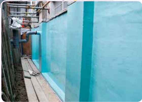
世界平和記念聖堂の後方、地下聖堂の防水工事の様子
