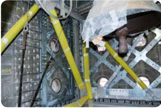
耐震補強工事を行った鐘楼内部 新たに取り付けられた鉄骨フレーム
