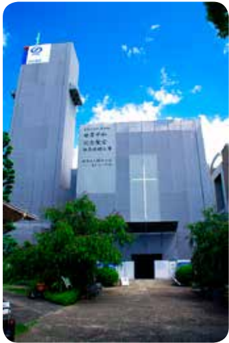
外壁工事のための保護シートで覆われた聖堂
