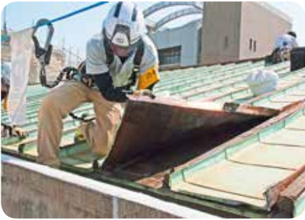
屋根銅板葺き替え工事
