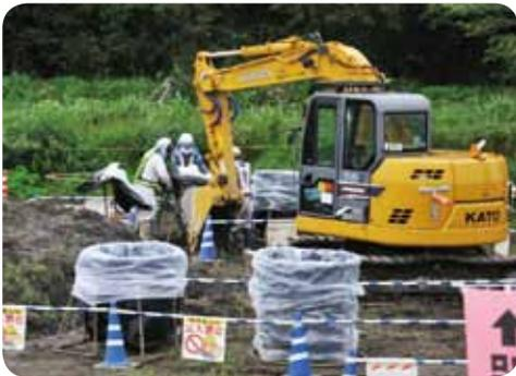
飯館村での除染作業の様子。防護服を着ている作業員が重機で原発汚染土をトン袋に入れている。
