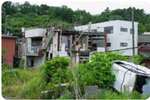
今もなお津波の被害がそのままに。富岡町の様子
